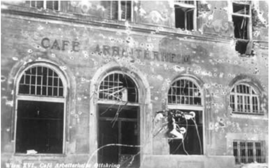
Zerstörte Fassade des Cafés Arbeiterheim (Ausschnitt): Mit Feldhaubitzen, Maschinengewehren und Minenwerfern gingen Militäreinheiten und Sicherheitswache in den Februartagen 1934 gegen die Verteidiger des traditionsreichen Hauses der Wiener Arbeiterbewegung (Kreitnergasse 29–33/Klausgasse 30–32) vor.
