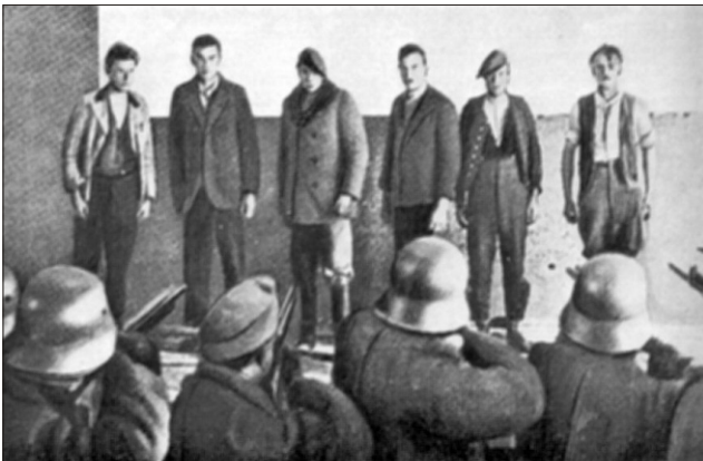
Auf der Theaterbühne des Arbeiterheimes Holzleithen wurden von der Heimwehr mehrere Schutzbund-Samariter erschossen (Aufnahme später nachgestellt)
